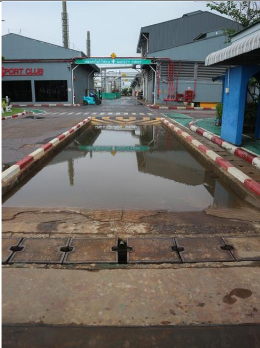
รูปที่ 2.1-16 บ่อล้างล้อบริเวณหน้าโรงงาน
