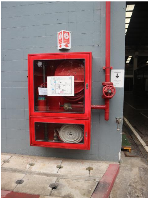
รูปที่ 2.1-36 ระบบดับเพลิงแบบสายสูบล
