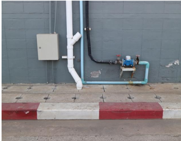
รูปที่ 2.1-19 รูปท่อรวบรวมน้ำฝนไม่ปนเปื้อน
