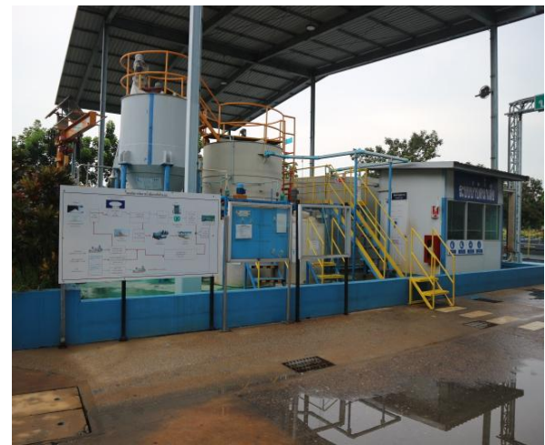
รูปที่ 2.1-12 ระบบบำบัดน้ำเสียทางเคมีของโครงการ
