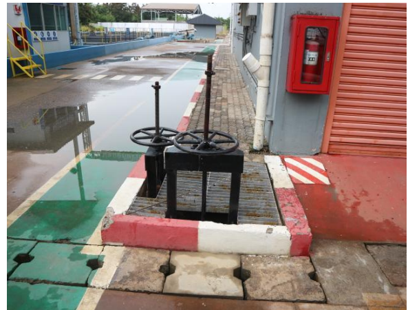
รูปที่ 2.1-18 รูปท่อรวบรวมน้ำฝนบนเพ็อน ก่อนเข้าสู่ระบบบำบัดน้ำเสีย
