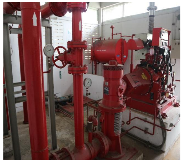
รูปที่ 2.1-37 ระบบเครื่องสูบน้ำดับเพลิง ระบบ Vertical pump
